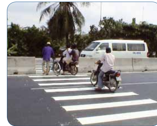
Figure 5 - Ouverture d'un séparateur en béton et signalisation de passage piétons (Vietnam)
